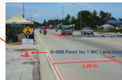
Chiang Mai-Mae Rim Highway, Thailand extensão = não indicado largura = 3.0m
